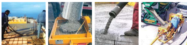
pompe per calcestruzzo
