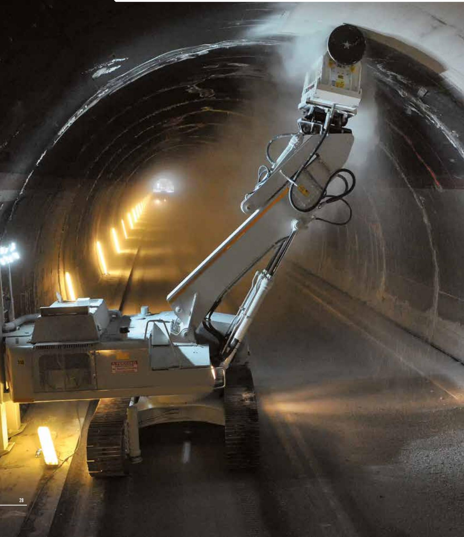
■ La fresatrice per profilatura Simex MP, montata su bracci escavatori, garantisce una finitura perfetta in lavori di precisione quali: rifacimento di volte di galleria, ripristino di superfici ammalmorate, sponde di canali in cemento, pavimenti industriali.
