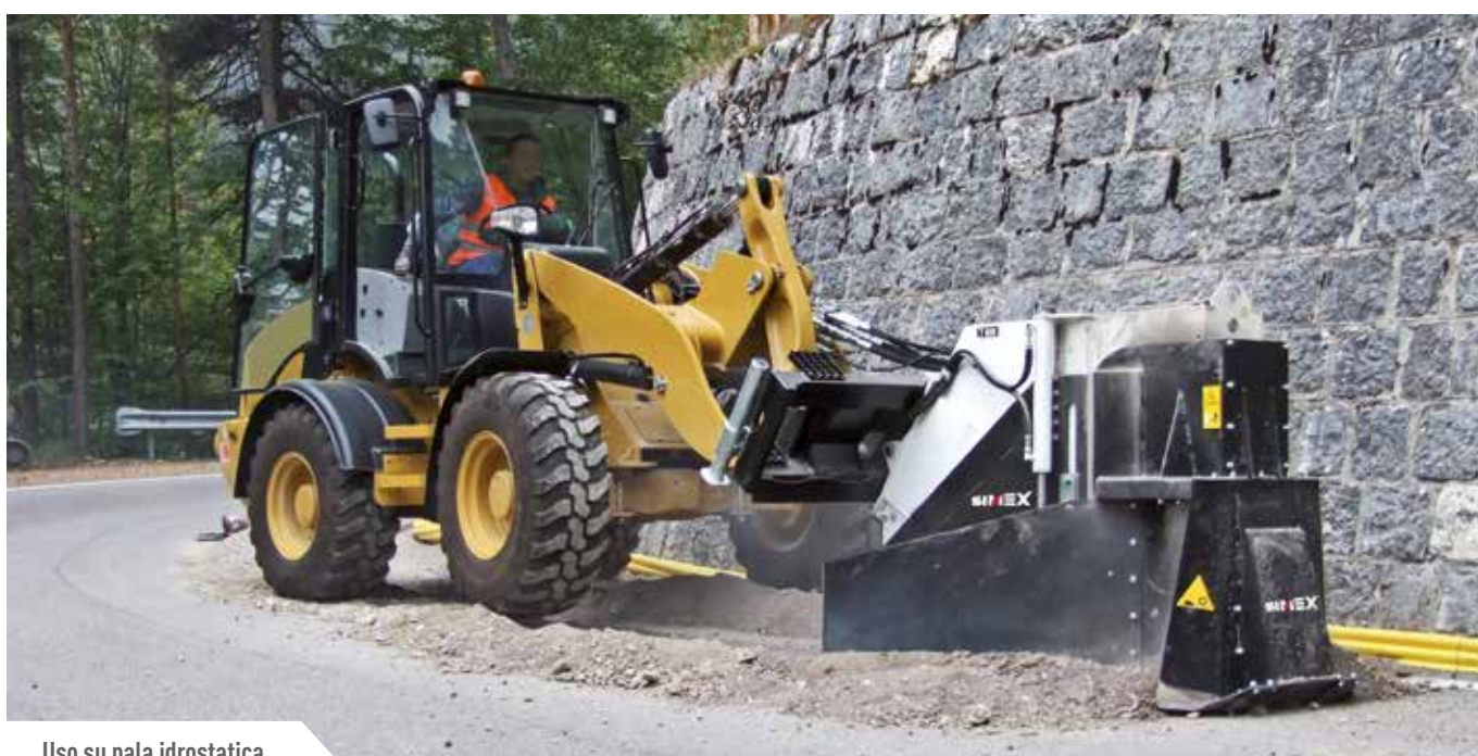
Aspirazione del materiale fresato
