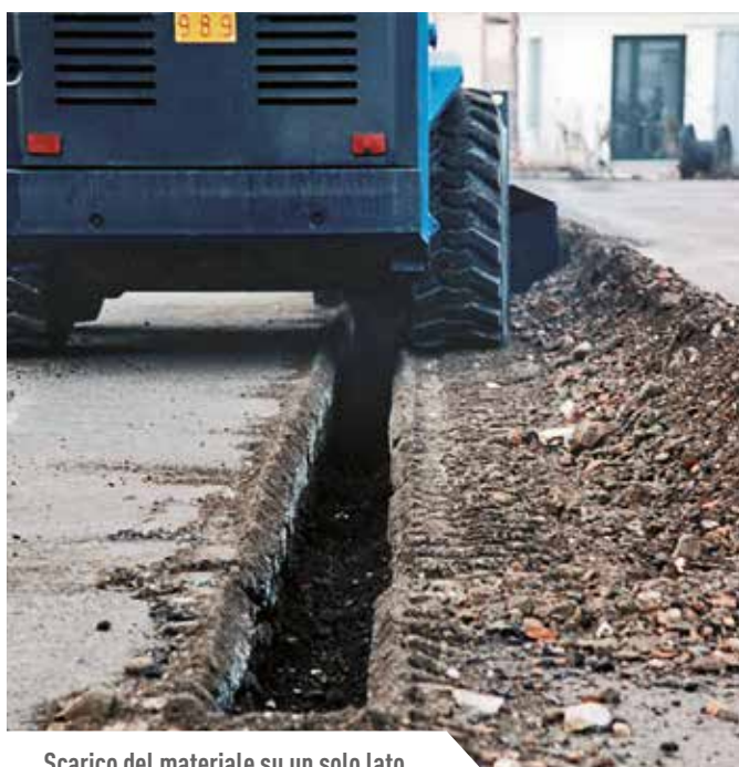
Scarico del materiale su un solo lato
