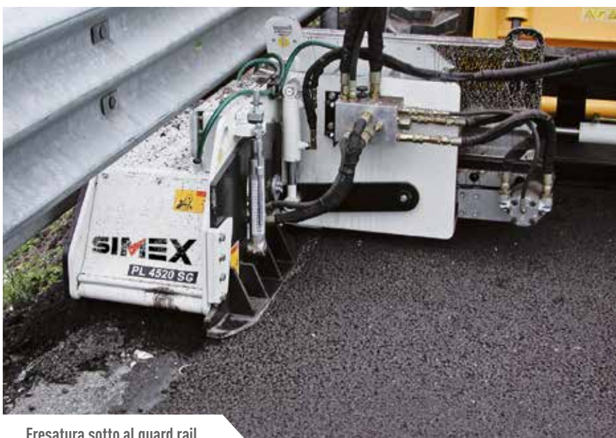
Fresatura sotto al guard rail
