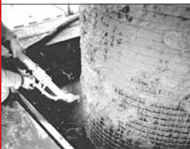
Spruzzatura di malta fibrinforzata o premiscelata
