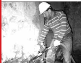
Iniezioni di boiacche cementizie a pressione controllata
