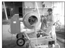
La S8 EV con betoniera
