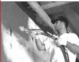
Spruzzatura di intonaco tradizionale o premiscelato
