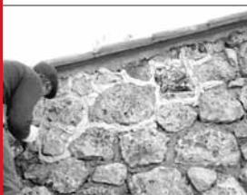
La portata variabile consente di effettuare il riempimento di giunti e connesure
